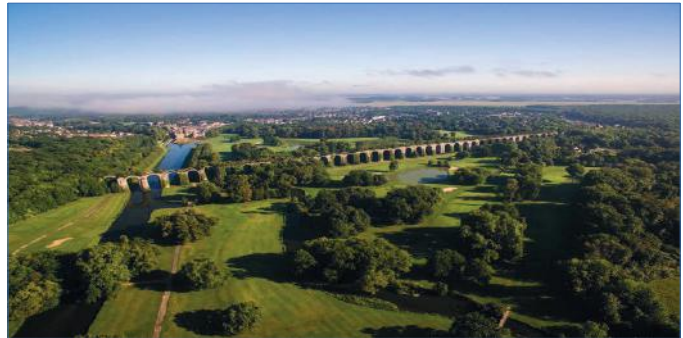
L'Aqueduc, un vestige inachevé à proximité du Château de Maintenon. Il devait, avec de grosses canalisations, faire traverser l'eau captée de Pontgouin vers Versailles, en permettant ainsi de garder un dénivelé suffisant, en surplombant la vallée de l'Eure.
