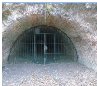
Siphon maçonné en pierre et en brique
