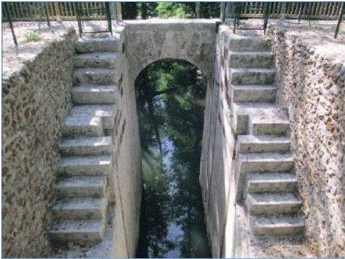
Ecluse de Boizard à Pontgouin
